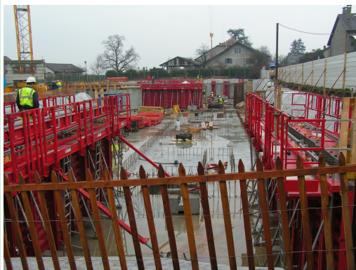
Chantier GYVI - Parking souterrain - 25.01.2010
